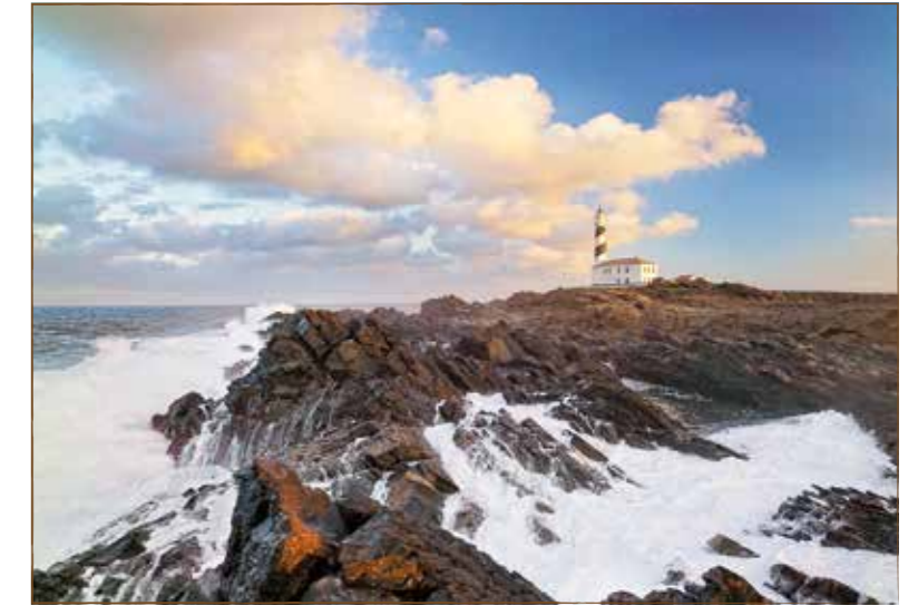
El Faro de Favàritx fue construido en 1992 para completar la iluminación de la costa norte de la isla tras varios naufragios durante la primera mitad del siglo XX. RB de Menorca.
