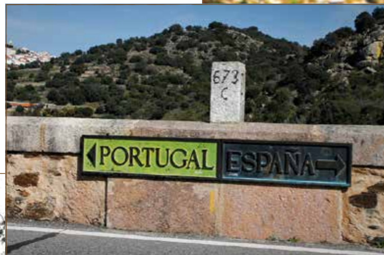
Puente Romano Internacional de Segura en el río Erjas, afluente del Tajo. Puede considerarse una réplica del Puente Romano de Alcántara en miniatura.
