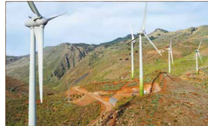
Abastecimiento de electricidad mediante la combinación de varios tipos de energías renovables, gracias a un innovador proyecto tecnológico, en RB El Hierro.
